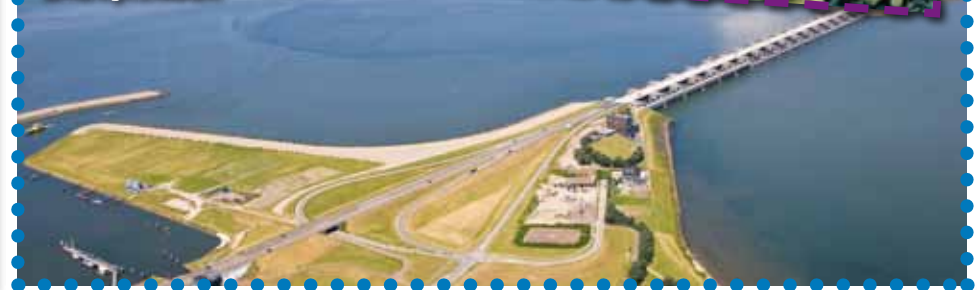
Brakke overgangszone bij de Haringvlietsluizen.
